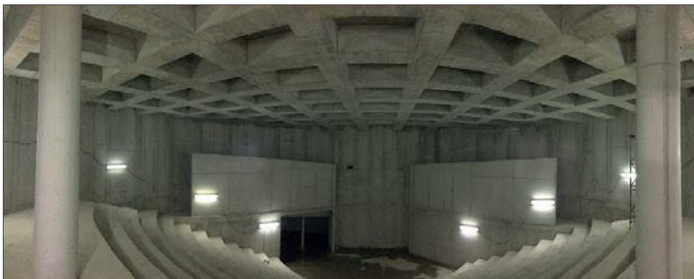
8. ábra: Campus épület – Nagy előadó terem alulbordás födéme
