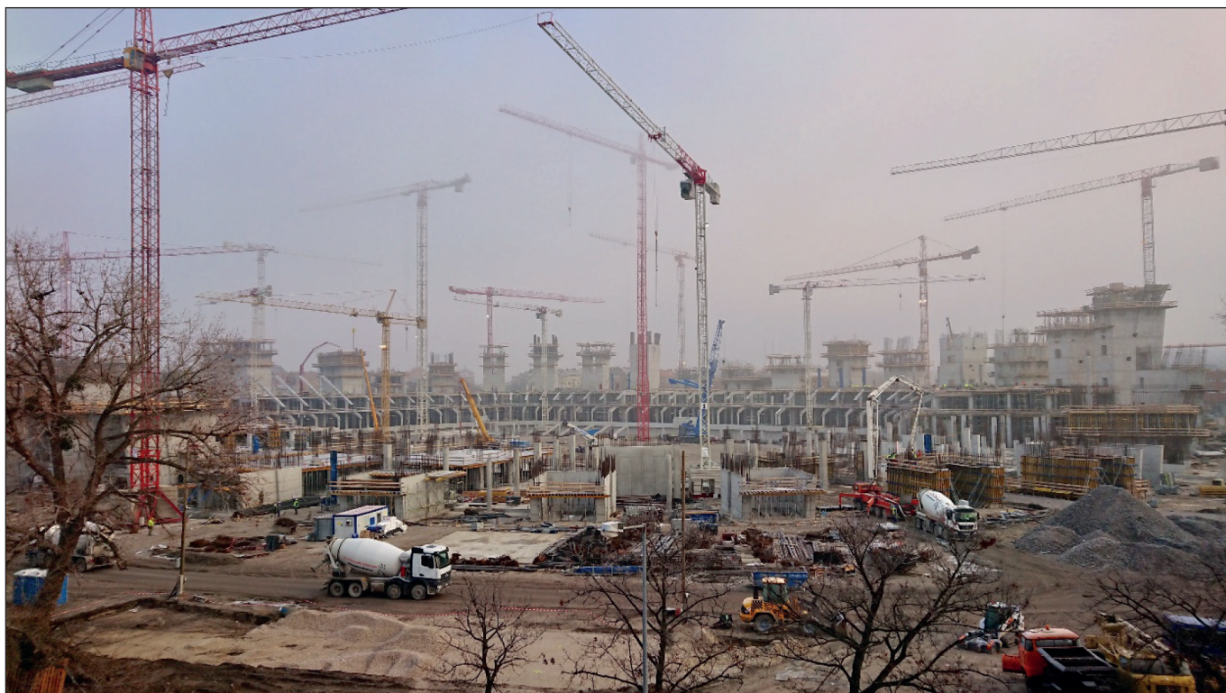
4. ábra: toronydarú, mobildarú, pumpa gémmel „erdő” szemléltetése
