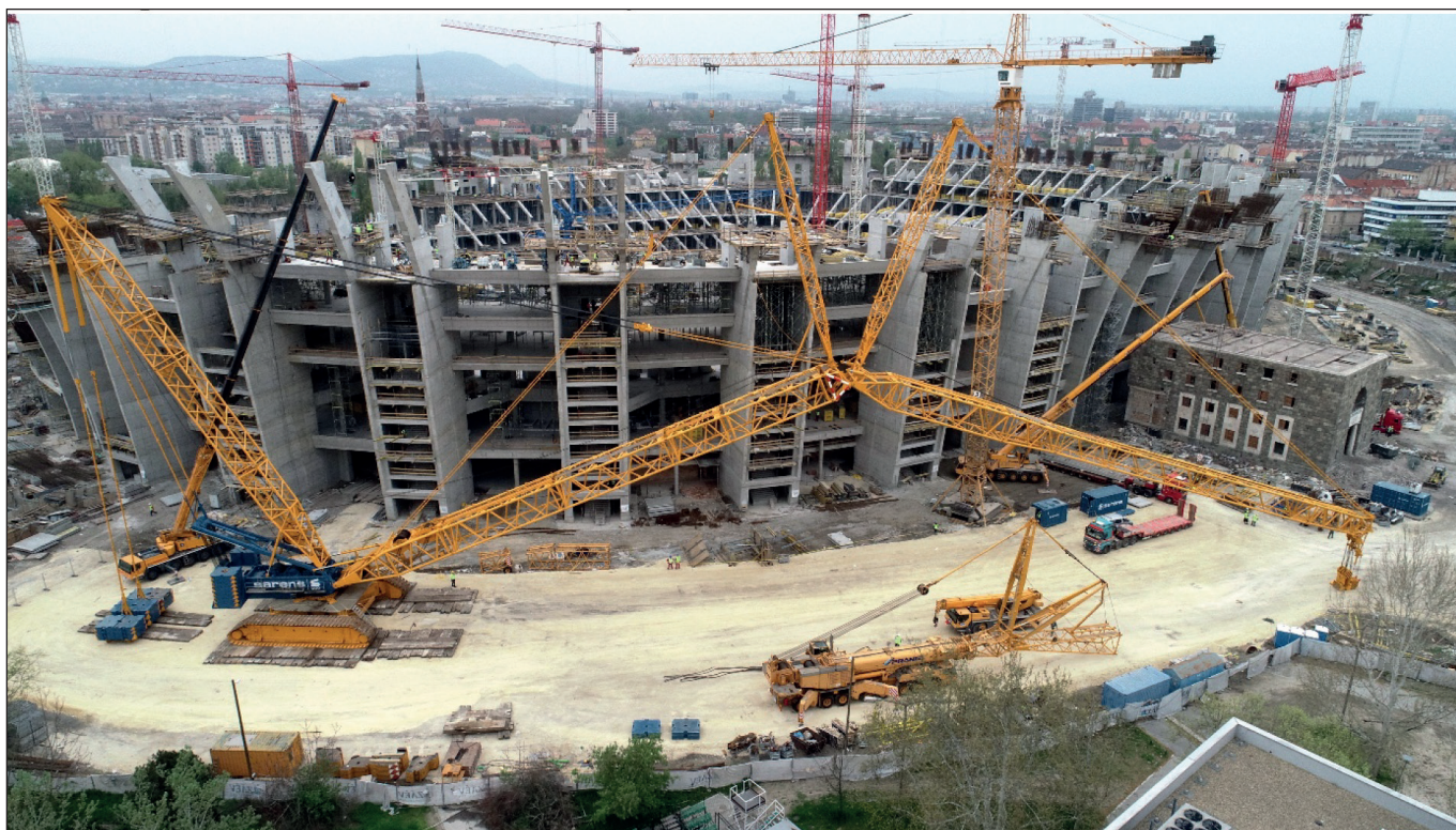
1. ábra: 1250 tonnás daru
